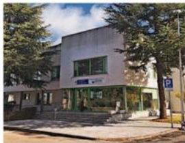
Edificio de Regtsa. DIPUTACIÓN DE SALAMANCA
